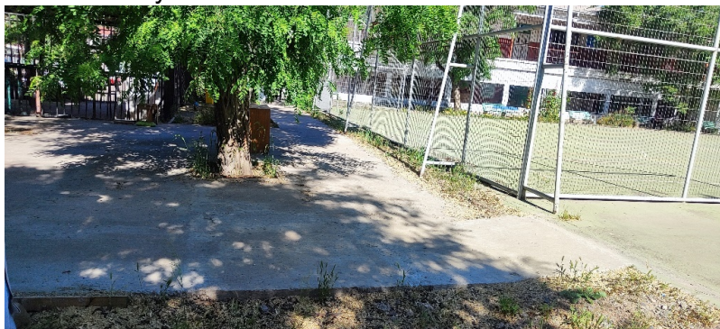
Ilustración 141: Radier conexión de pabellón a baños. CESFAM Recreo
