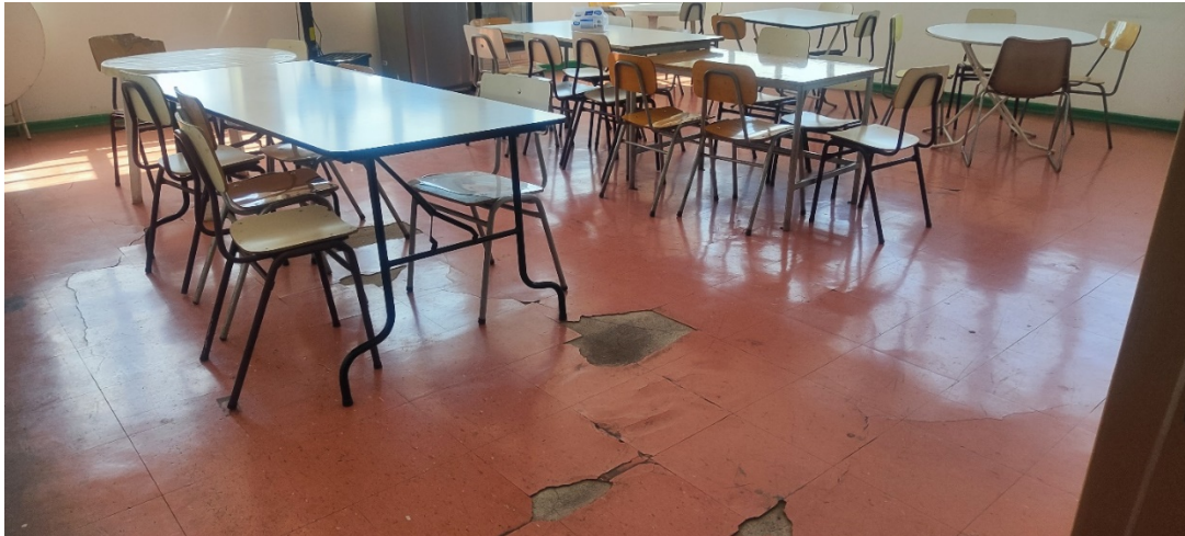
Ilustración 188: Comedor de funcionarios pabellón nor-orientado del 2° piso. CESFAM Recreo
